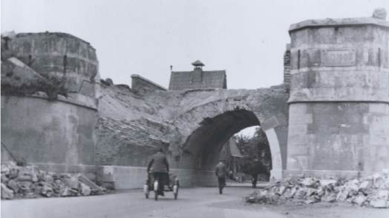
6b Westervoorts viaduct in april 1945 Locatie: Brugweg
