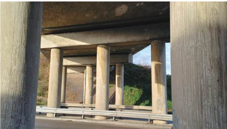
6c Huidige situatie Westervoorts viaduct Locatie: Brugweg
