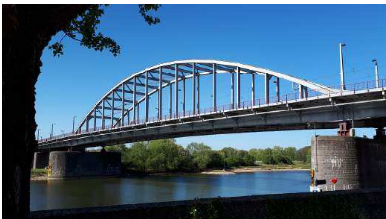
13c Huidige situatie Rijnbrug Locatie: Nijmeegseweg
