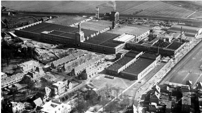
11a ENKA-fabrieken vòòr WOII (afbeelding Gelders Archief) Locatie: Westervoortsedijk
