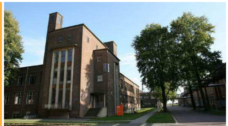
11c Huidige situatie Kleefse Waard (voormalige ENKA-fabrieken) Locatie: Westervoortsedijk
